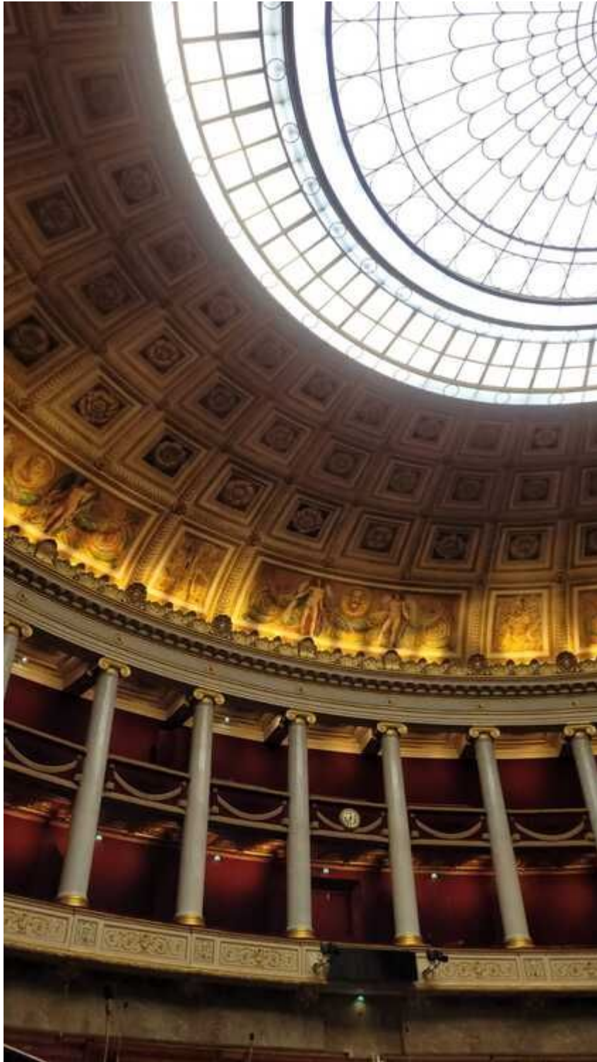
Photo 49 : La salle de séances est dotée d'une immense verrière qui fait office de puit de lumière. Cette large verrière du XIXème siècle en forme d'éventail, composée de panneaux en verre soutenus par une structure métallique, se déploie au-dessus de l'hémicycle.
